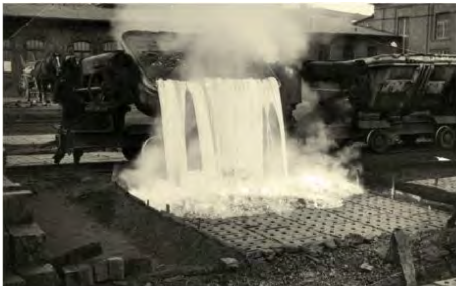
Bild 13: Herstellung von Schlackensteinen auf der August-Bebel-Hütte bei Helbra (Foto Archiv Mansfeld Museum, Hettstedt)
