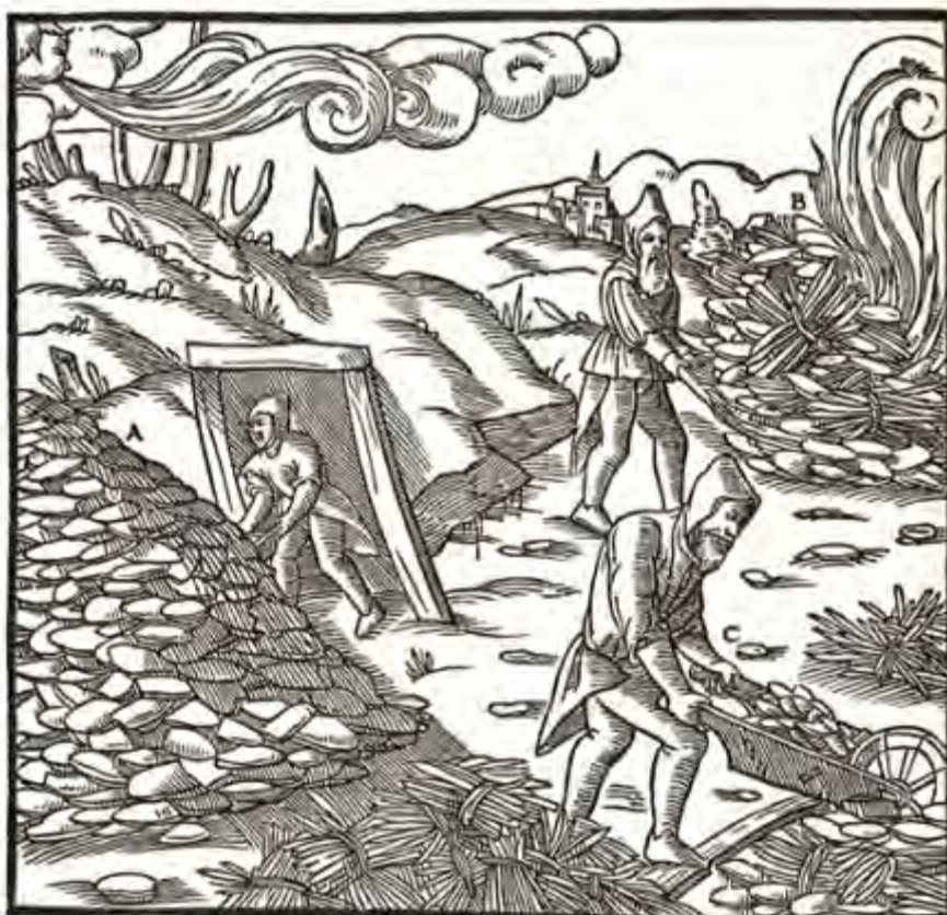
Der Erzhaufen A. Der entzündete Erzhaufen B. Ein Arbeiter, der Schiefer auf das Strauchwerk schafft C.
