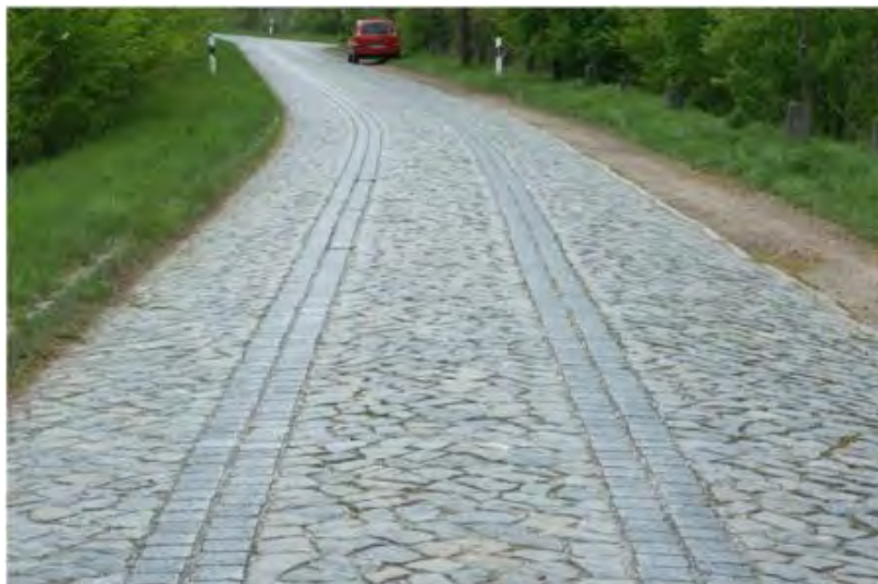
Bild 10: Schlackensteine im Verbund mit Naturstein als Straßenpflaster bei Grimschleben (Sachsen Anhalt, Foto Stedingk)
