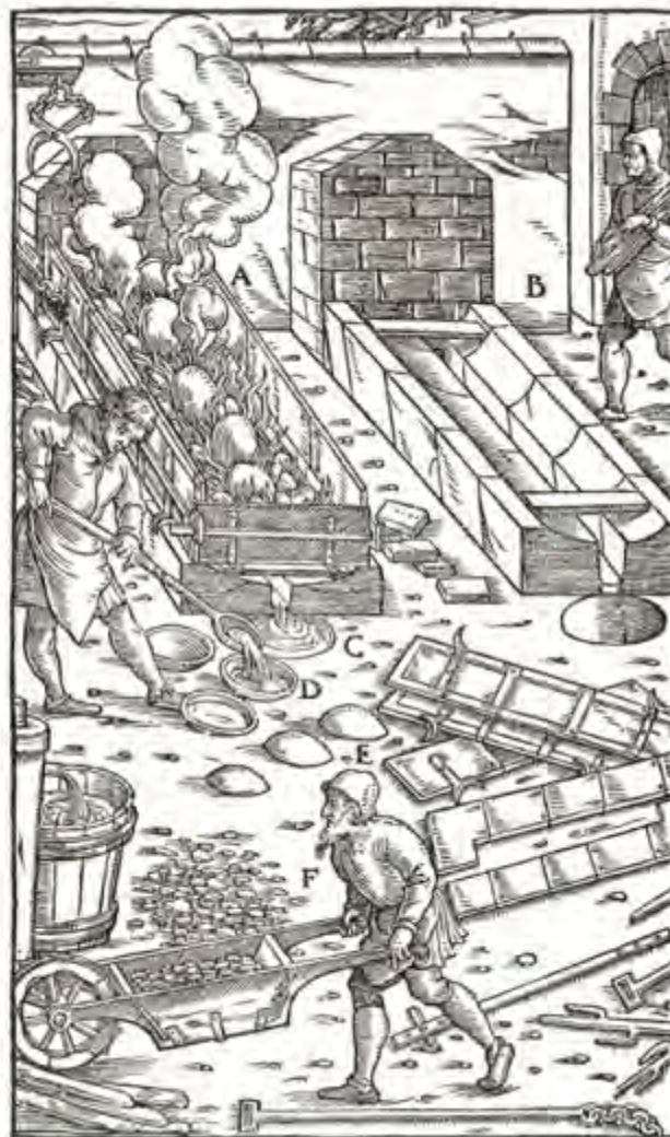
Der Saigerherd in Betrieb A. Derfelde außer Betrieb B. Der Sumpf C. Kleine runde Formen D. Kuchen von Saigerblei E. Saigerdörner F.
