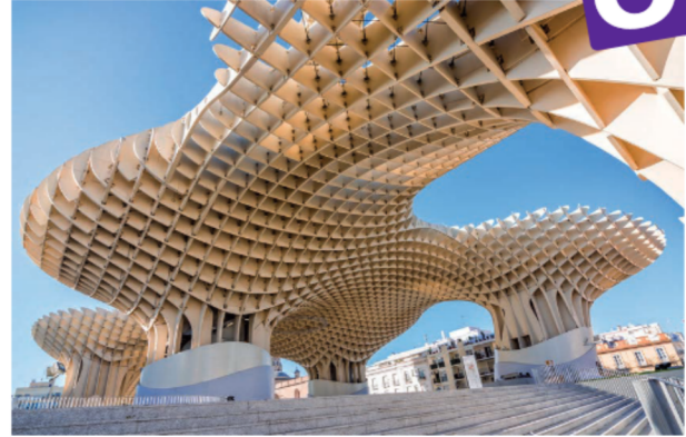
Abb. 97: Moderne Holzkonstruktion in Sevilla
