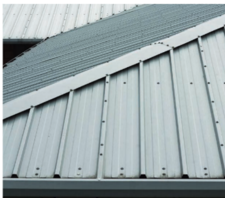
Abb. 10: Bedachung aus Aluminiumblech Quelle: © ClipDealer
